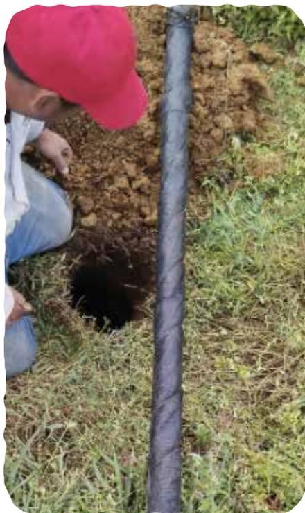
**Figura 12.** Instalación de freatómetro para monitorear el nivel freático del suelo.
